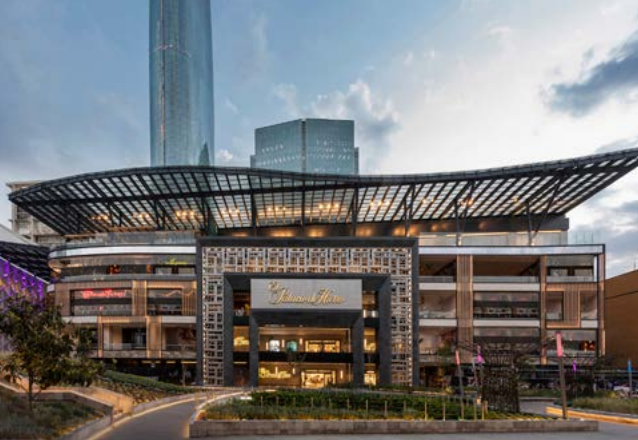
EL PALACIO DE HIERRO COYOACÁN
